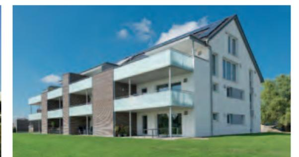
Dreigeschossiges Mehrfamilienwohnhaus mit zwölf Wohnungen (73–143 m<sup>2</sup>) in Holzrahmenbauweise: Ausgeführt als Effizienzhaus 40 mit Erdwärmepumpe, zentraler Lüftungsanlage mit Wärmerückgewinnung sowie Photovoltaikanlage
