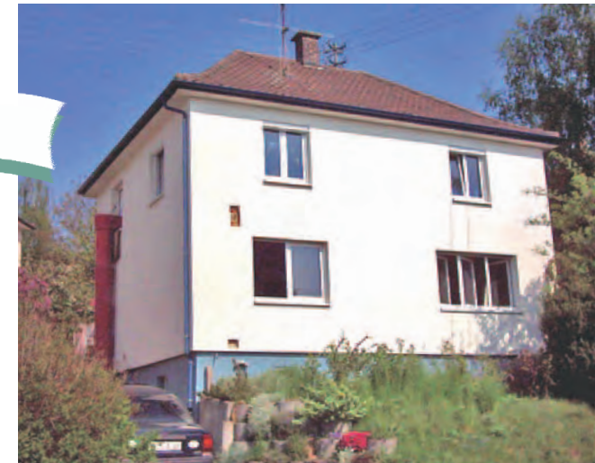
Vorbereitungen der Baumaßnahme: Hausansicht von der Straße
