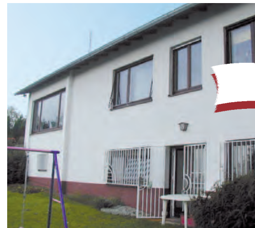
Hausansicht vom Garten – vorher ...
