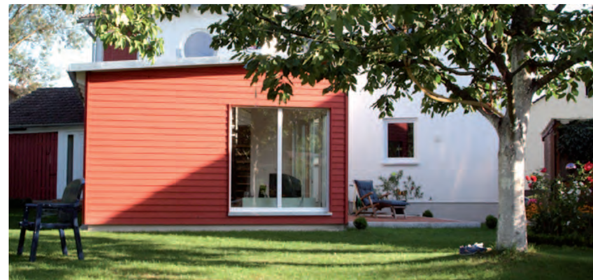
Seitenansicht vom Garten auf den Anbau (oben)
