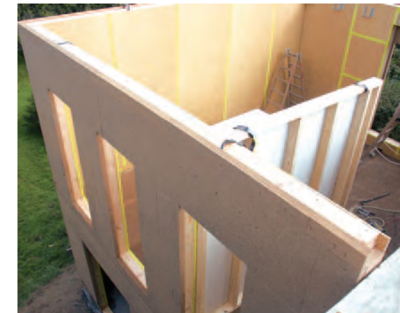
Vorgefertigte Holzrahmenwände mit integrierter Dämmung
