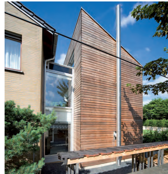
Seitenansicht mit Übergang zum alten Gebäude
