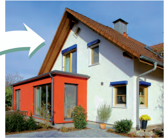
Zwei große Wandöffnungen führen vom alten Haus in den L-förmigen Anbau
