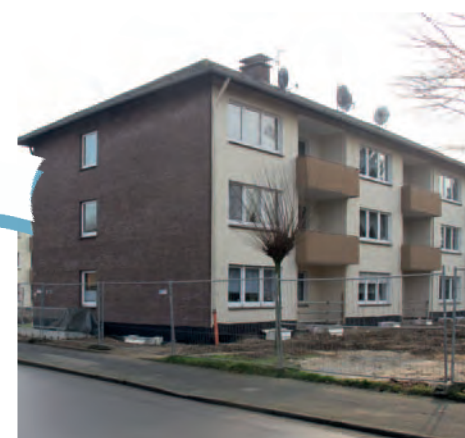
Das Gebäude von 1967 vor der Modernisierung
